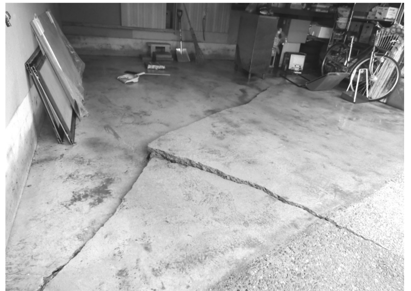
液状化により噴き出した砂(左)と、コンクリートのひび割れ(右)
