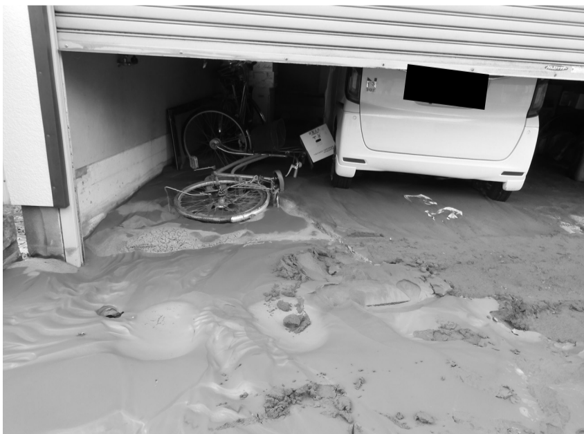
液状化により噴き出した砂(左)と、コンクリートのひび割れ(右)
